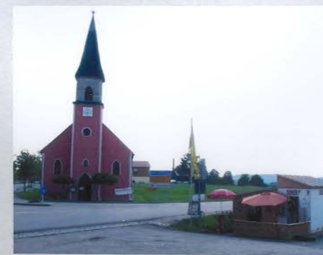
Autobahnkirche Vohenstraußer Straße
