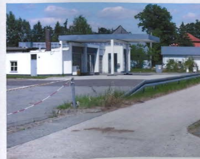
Ehem. Tankstelle Vohenstraußer Straße
