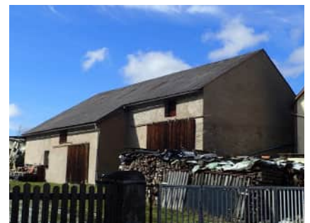
Potenzial: Nebengebäude ohne Dachaufbauten
