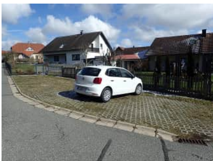
Versickerungsfähige Parkplatzbeläge
