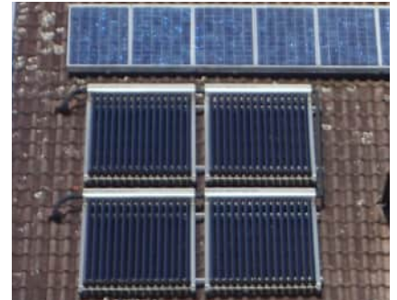
Kombination aus Solarthermie- und PV-Anlage
