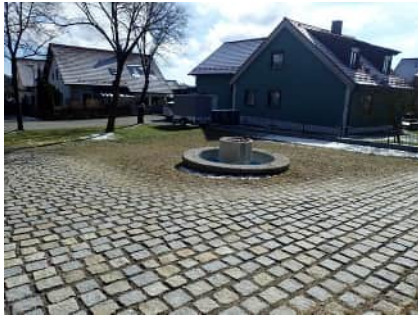
Breite Fugen verbessern die Versickerungsfähigkeit
