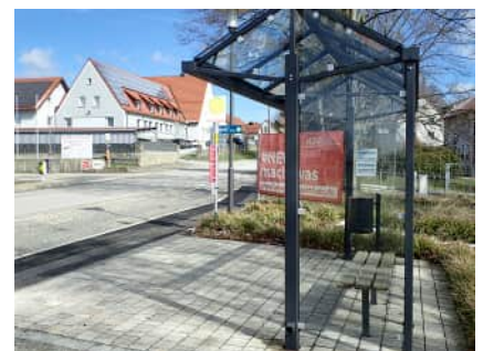
Barrierefreie Bushaltestelle a.d. Autobahnkirche
