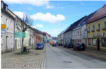
ortsbildprägende Hauptstraße - Ensembleschutz
