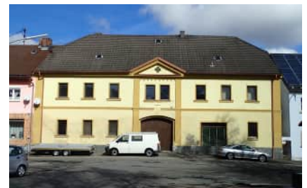
Marktplatz 3 - raumprägendes Gebäude durch Neunutzung zu aktivieren
