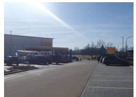
Potenzial: großflächiges Flachdach und Begrünung Parkplatz
