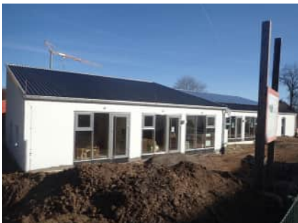
Bahnhofstraße - Kindergarten Erweiterung
