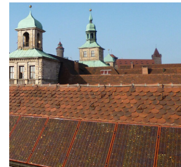
Farblich an die Dachdeckung angepasste, Indach-Lösungen sind am besten vereinbar mit den Zielen des Denkmalschutzes.
